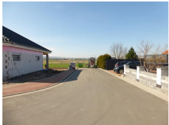
Foto 5: Vorbereiteter Straßenanschluß im nördlichen Bereich des B-Planes 16-05 „Söhleke-Süd“
